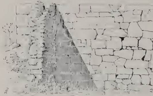
Fig. 63. Polygonales Mauerwerk mit Abgleichungsschichten von der Burg zu Argos.
